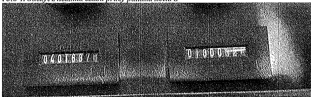
Foto 4: Odczyt z licznika czasu pracy palnika kotła I.
